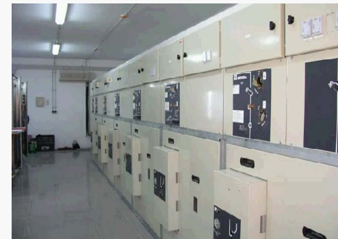
Quadro fixo modular com disjuntores de vácuo
