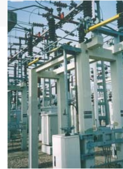
Seccionador horizontal de abertura central 72.5kV
