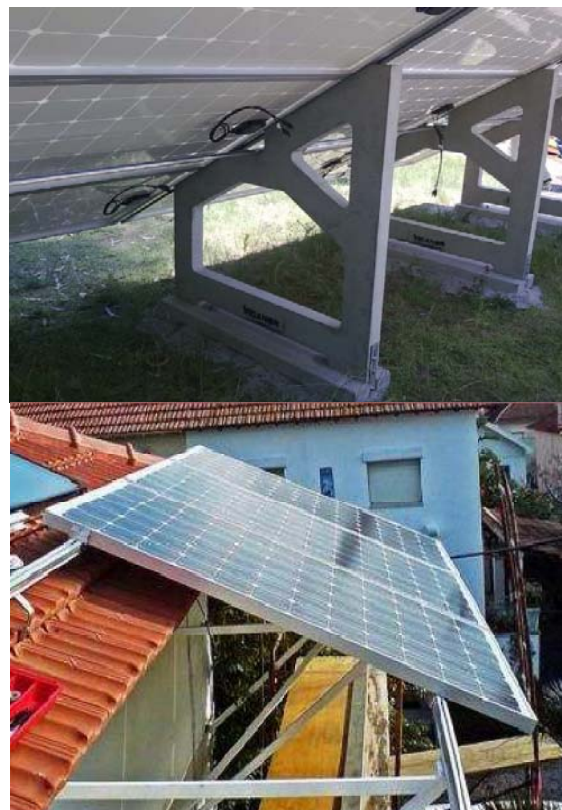
Fig. 8- Exemplos de estruturas de suporte
