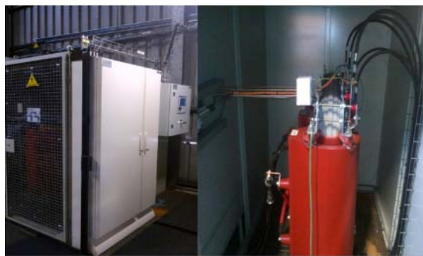
Figura 6. Posto de transformação de miniprodução
