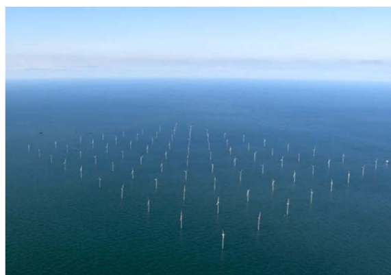
Figura 2 – Parque eólico de Horns Rev
