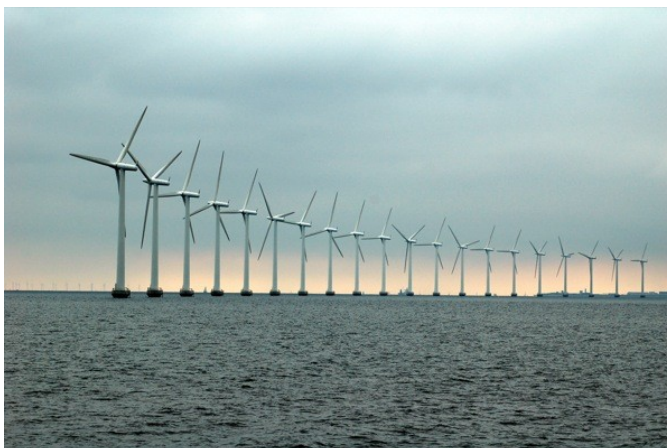
Figura 2 – Parque eólico de London Array no Reino Unido (London Array)
