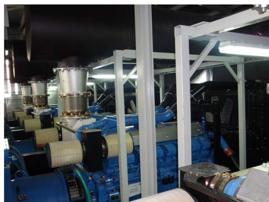
Figura 5. Instalação de um grupo eletrogéneo em sala técnica
