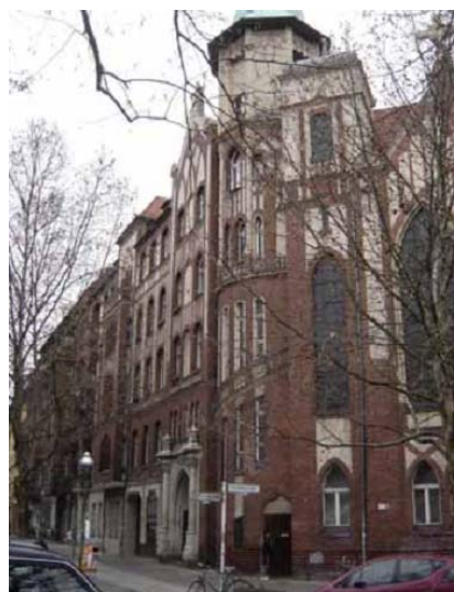
Fig. 1 – Vista do edifício em estudo
