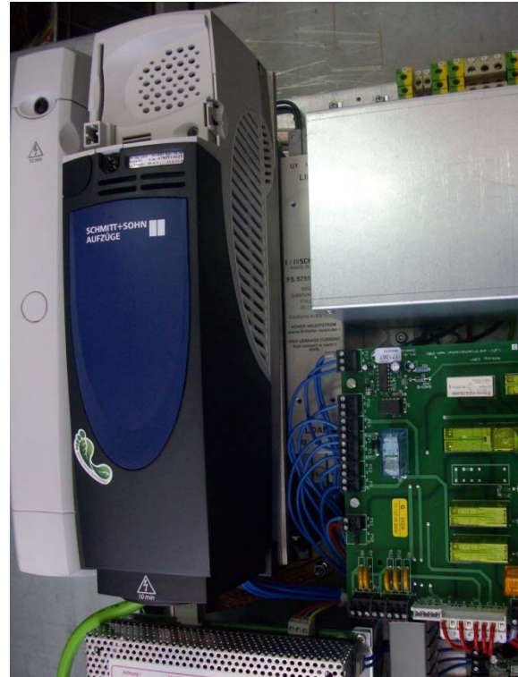
Figura 5 – Variador eletrónico de frequência (Fonte: Schmitt+Sohn Elevadores)
