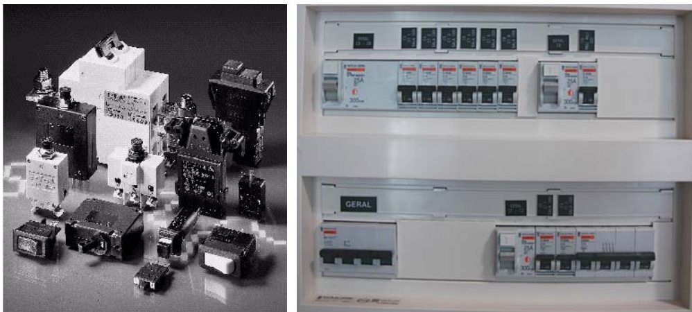
Figura 3: Vários tipos de relês de protecção (esquerda) e quadro do Laboratório I305 (direita)
